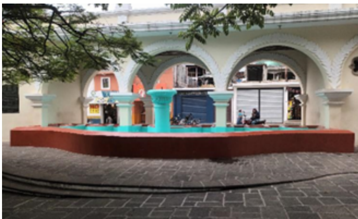
Figura 2. Vista de la pila de la plaza central de San Antonio Aguas Calientes.
